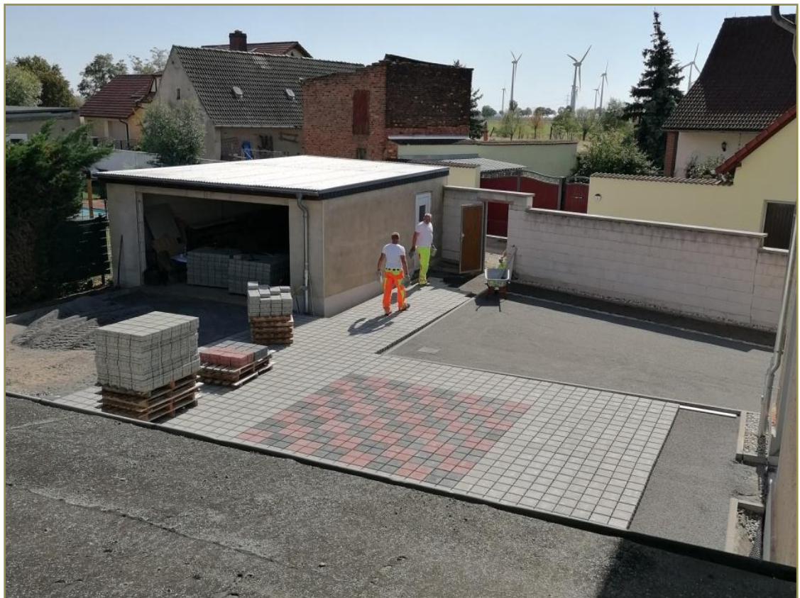
Ein Blick aus dem Archiv-Fenster: Der Innenhof der Turnhalle nimmt Gestalt an
